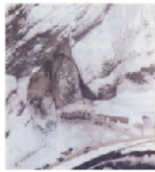
豊浜トンネル (1996:11,000㎡)
