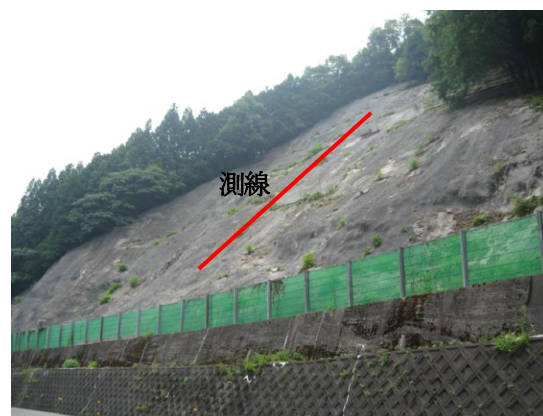
図-2 吹付け法面（A地区）
