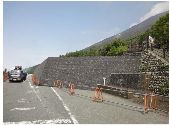
図-14 新しく建設された補強土防護擁壁工の写真 (側面から, 2010年7月)
