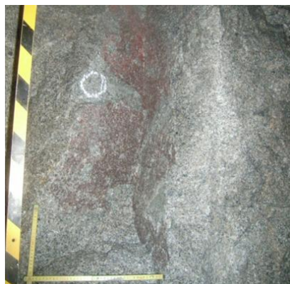
写真-1 グラウト充填割れ目の例 (G.L. -434m付近)
