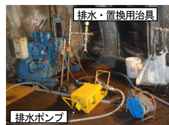
写真-5 グラウト孔内の排水・置換状況
