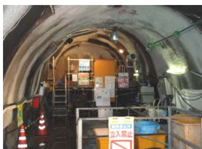
写真-2 施工試験状況（試験中、立坑側から撮影）
