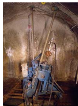
写真-6 流出抵抗性試験の実施状況
