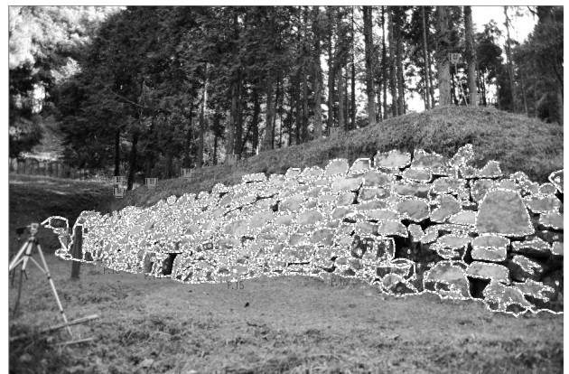
図-11 組石の縁のベクトル化処理の結果と写真画像の合成
