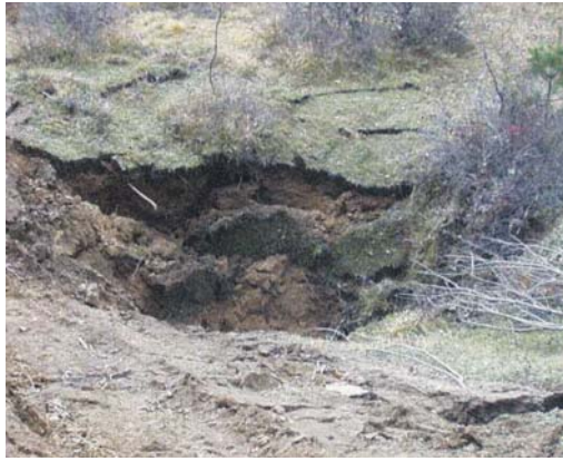
図-2 1999 Düzce地震によるBoluトンネルの地表面に見られる陥没 3-7)
