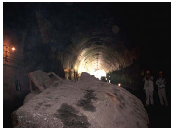
図-1 2008年中国・四川省地震によるJiujiayaトンネルにおける被害の様子 5-7)
