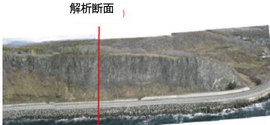
写真-4 落石シミュレーション対象斜面
