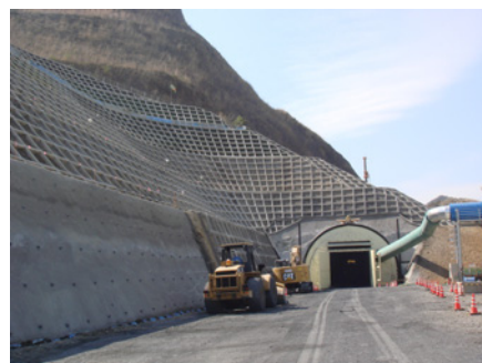
写真-11 LEISによる坑口斜面監視適用現場の状況
