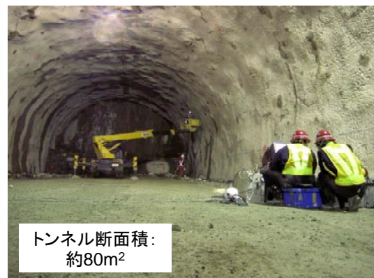
写真-4 Bトンネルでの探査状況
