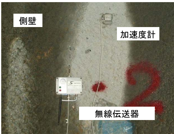
写真-5 無線伝送器設置状況
