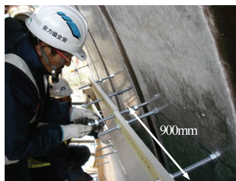
図-9 ボードの設置方法
