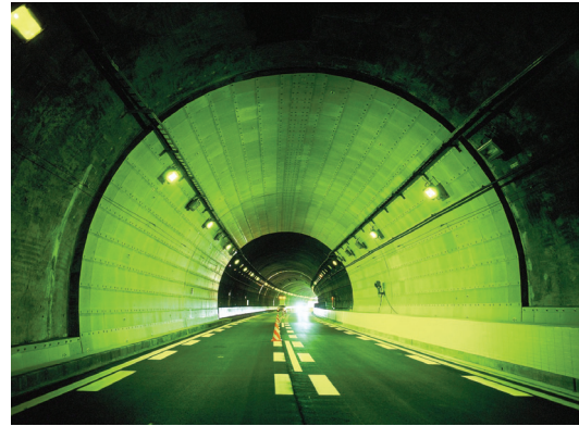
図-19 本工法による内巻補強工
