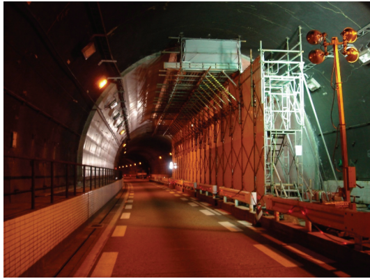
図-18 天端部施工
