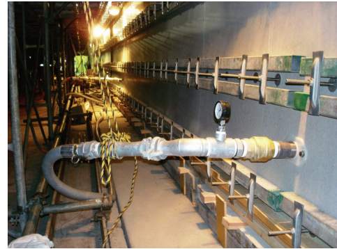
図-10 充填モルタル注入
