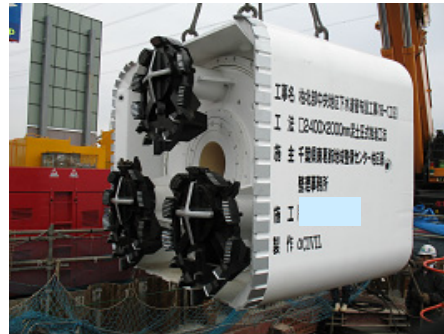
写真-3 ボックス掘進機全景
