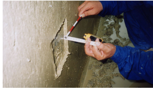
写真-7 テールボイド状況②
