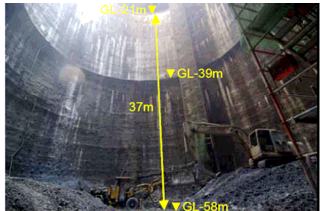
図-14 換気立坑内施工状況写真
