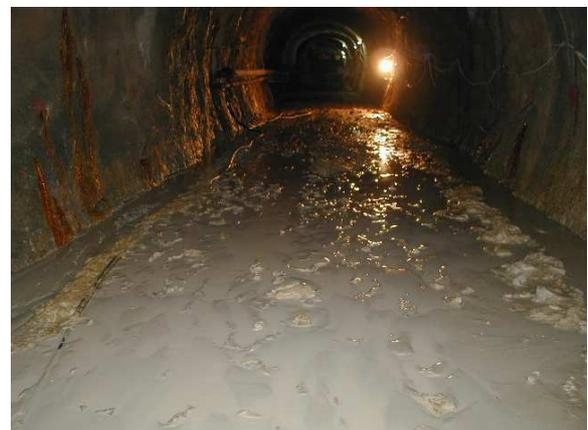
写真-2 火山灰が流出したトンネル内部(最大厚さ75cm)
