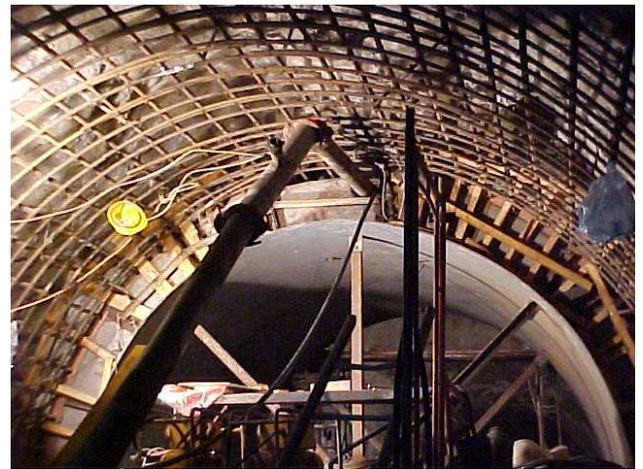
写真-4 コンクリート打設前鉄筋敷設状況
