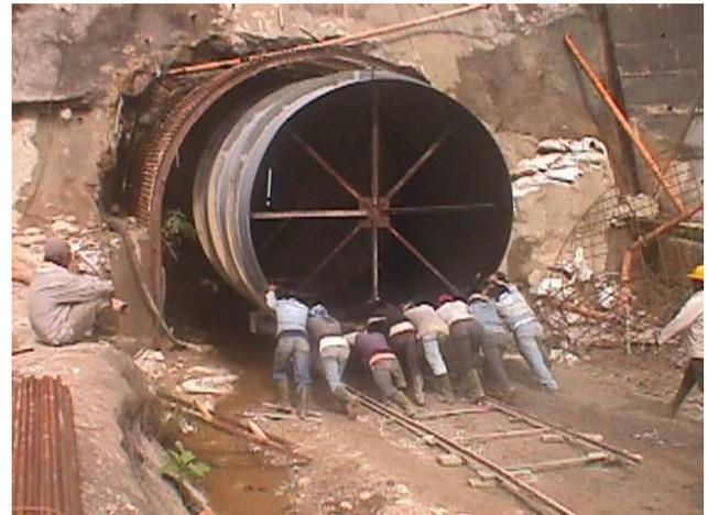
写真-3 内張鉄管敷設状況
