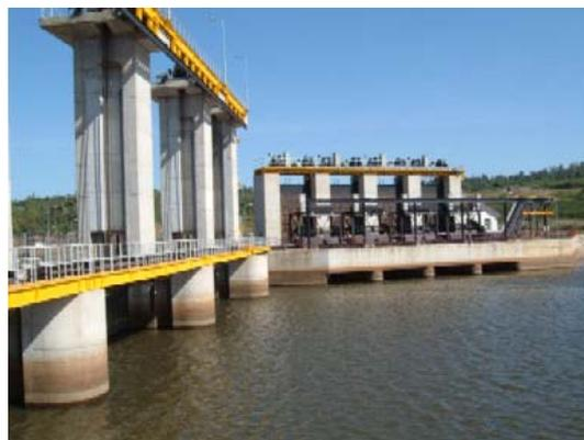
写真-6 取水堰と取水口
