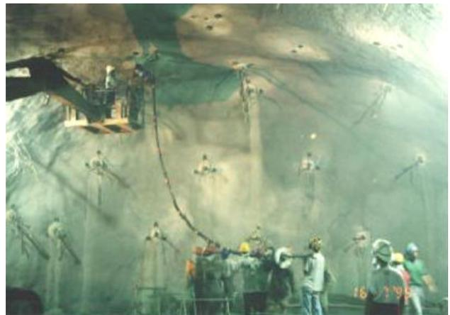
写真—2 PS アンカー挿入作業
