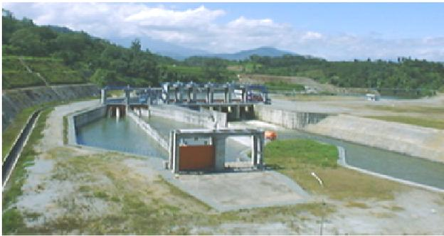
写真-1 取水ダム及び沈砂池
