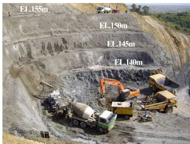
写真-2 明かり掘削施工状況
