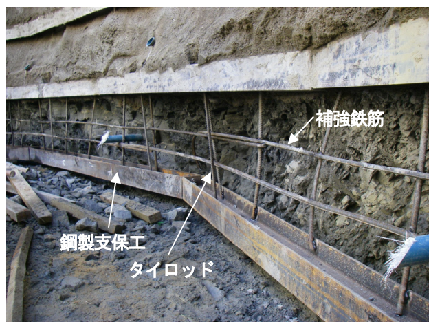
写真-4 立坑掘削状況
