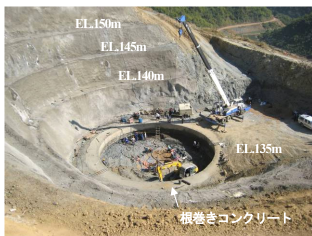
写真-3 立坑掘削施工エリア全景
