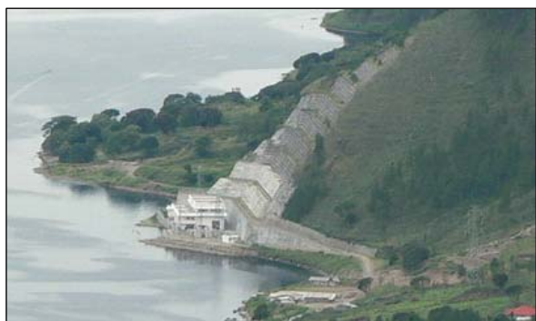
写真-3 発電所全景
