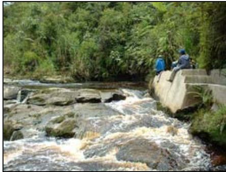
写真-14 既設灌漑取水設備(改修前)
