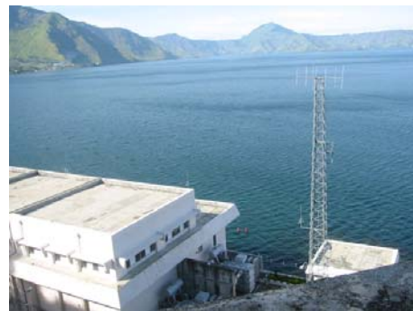
写真-12 運転開始後の湖水状況
