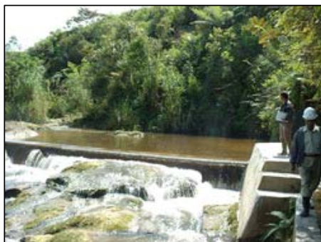
写真-15 既設灌漑取水設備(改修後)
