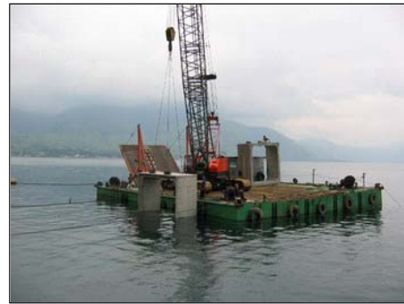
写真-11 カルバートの沈埋
