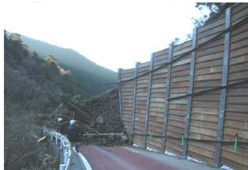
写真-1 崩壊後の状況
