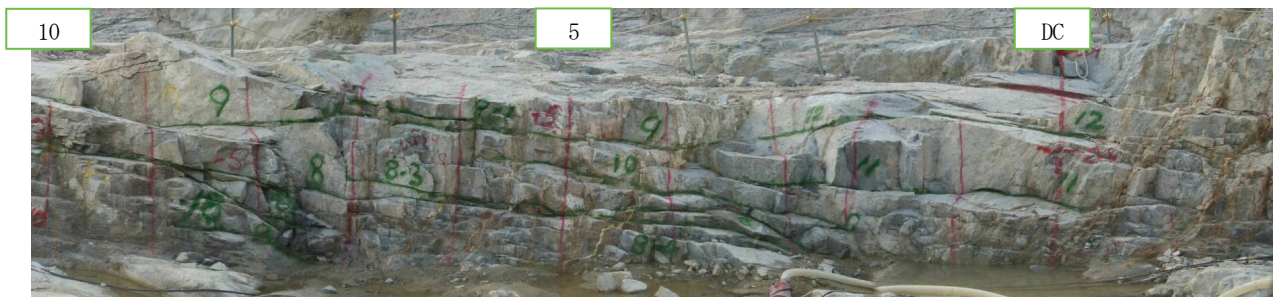
写真-5 J15沿い（掘削面傾斜部）の調査範囲の状況（部分）
