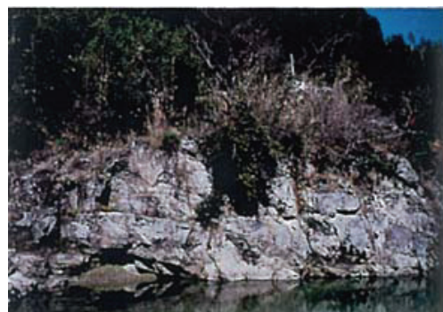
写真-2 現地踏査時の低角度割れ目
