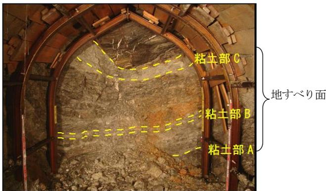
図-3 調査横坑内で確認された地すべり面の状況
