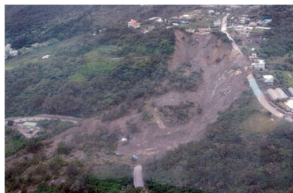
図－６ 北上原斜面崩壊の状況（沖縄県提供）
