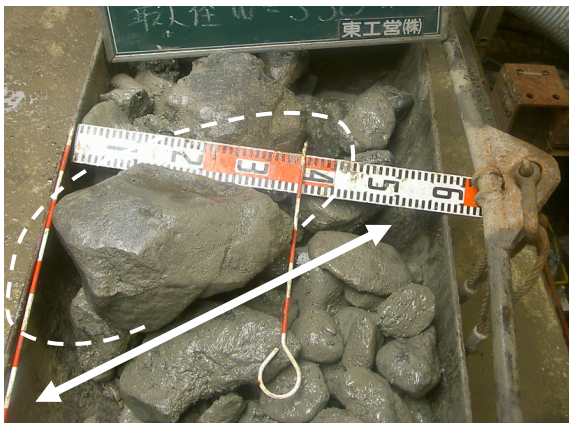
写真-6 掘進中に掘削破碎された巨石片
