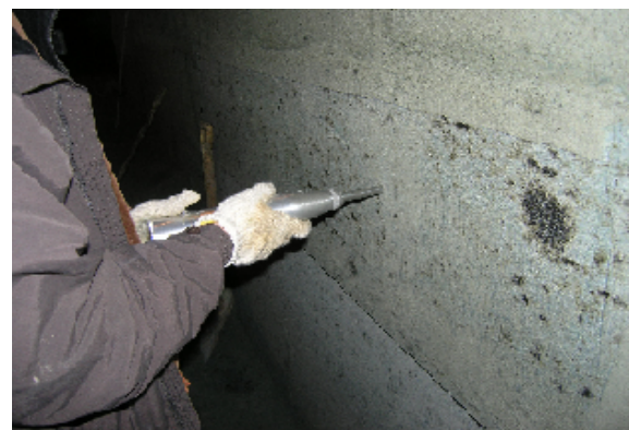
図-3 大谷採石地下空間におけるハンマー反発度測定状況
