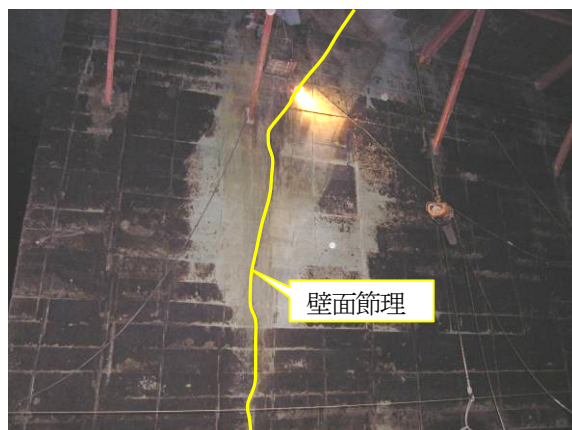
図-10 採石地下空間 A の壁面にある節理
