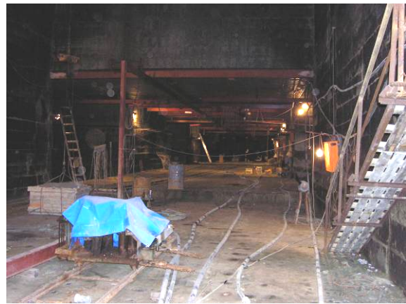
図-2 採石地下空間 B の立坑付近
