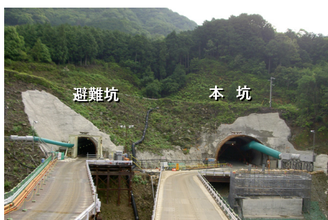
写真-1 新八鬼山トンネル坑口(三木里側)
