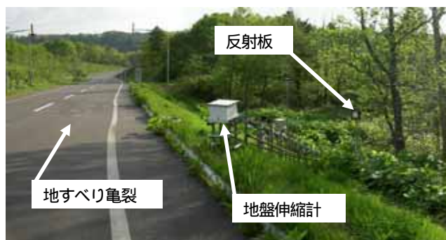
写真-4 反射板と地盤伸縮計設置状況
