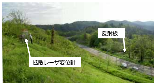
写真-3 拡散レーザ変位計設置状況
