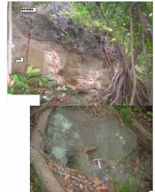
上部斜面の露岩状況 (安山岩, 下層が凝灰角礫岩)
