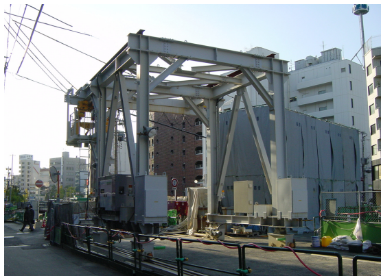
写真－５ 推進設備設置状況（地上）
