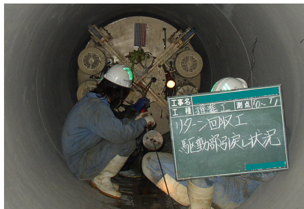
写真－10 掘進機駆動部リターン回収状況
