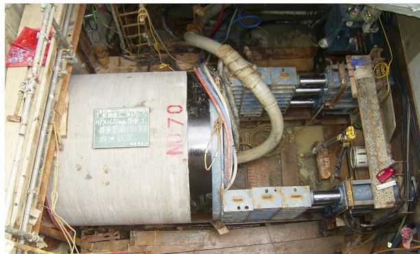
写真－２ 推進状況
