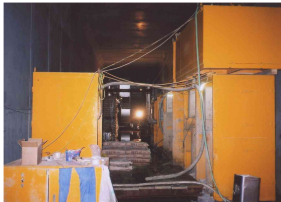
写真－６ 推進設備設置状況（ボックスカルバート内）
