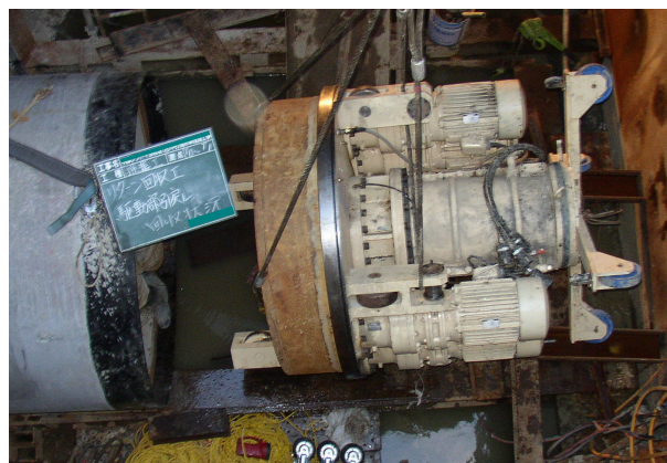
写真－11 掘進機駆動部搬出状況
