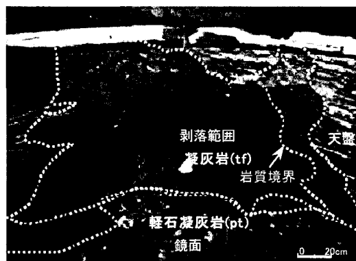
図-4 天端付近の剥落状況
