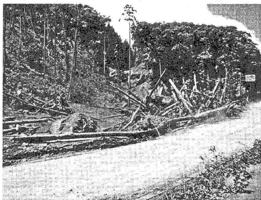
写真－1 都道の被災状況
