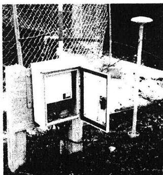
写真1 センサー設置状況
