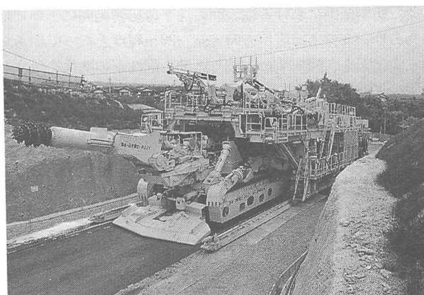
写真-2 全断面对应型自由断面掘削機と多機能型ガントリージャンボの組合せ
