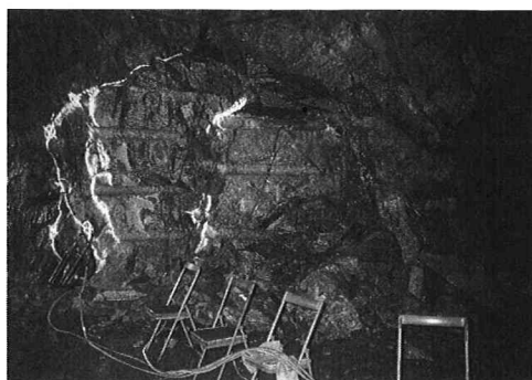
図－8 現場試験における割岩拡幅状況
