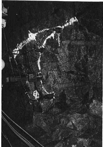
図-7 現場試験における割岩状況
