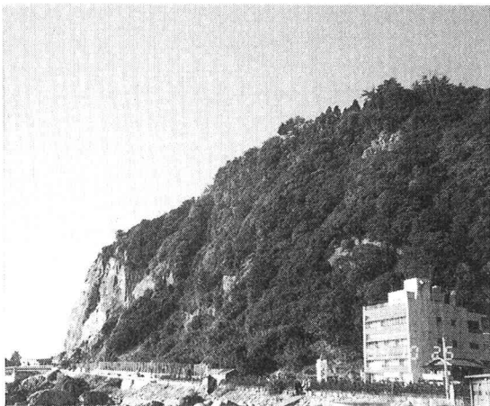
写真-1 南方より見る斜面全景
