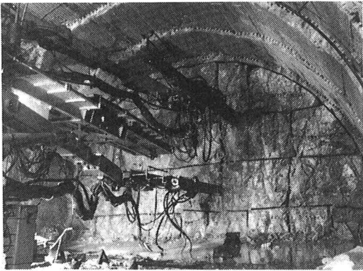
写真－1 スロット削孔状況
