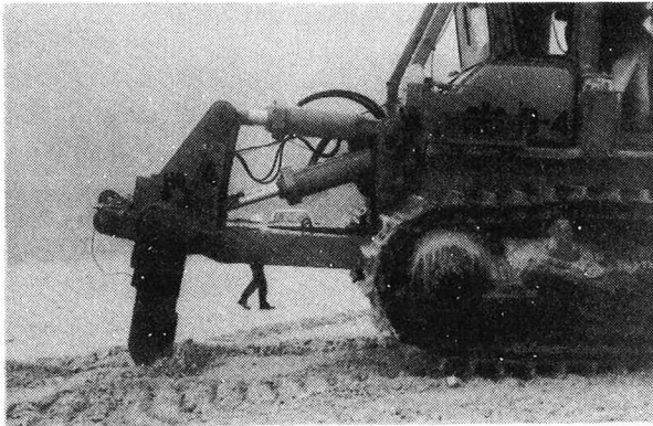
写真2 掘削力測定中の50トン級ブルドーザー
