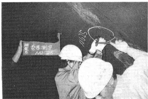
写真 8 道路トンネル覆工巻厚調査測定状況
