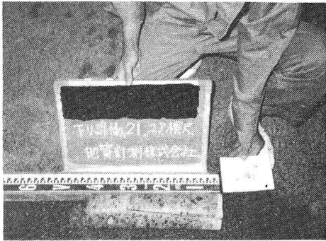
写真6 鉄道トンネル路盤調査B地点のコア採取状況
