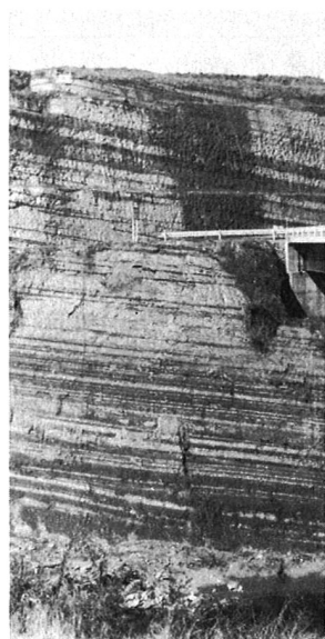
写真2 現場試験をおこなった軟質岩盤(砂泥互層)、崖の高さは約35m
