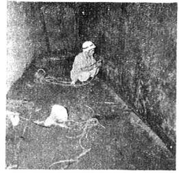
写真-1 PVC板溶接状況
