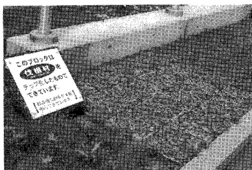
図-6 国土交通省東北地方整備局能代河川国道事務所で の施工 (フラッグポール周辺部)
