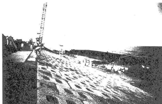
写真-15 吸出しによりり面の陥没が起きた緩傾斜護岸の復旧工事
