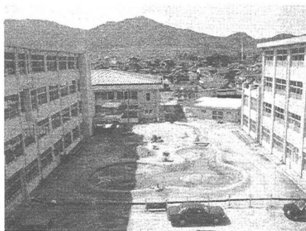
図-8 施工された中庭の水辺ビオトープ
