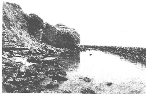
写真-5 小動岬の海蝕崖と離岸堤(1999年4月15日撮影)
