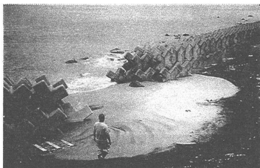
写真-9 木野部海岸の消波堤の状況(1999年7月23日撮影)
