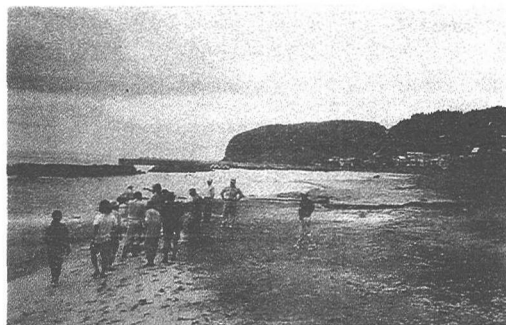
写真-8 木野部海岸の離岸堤状況(1999年7月23日撮影)
