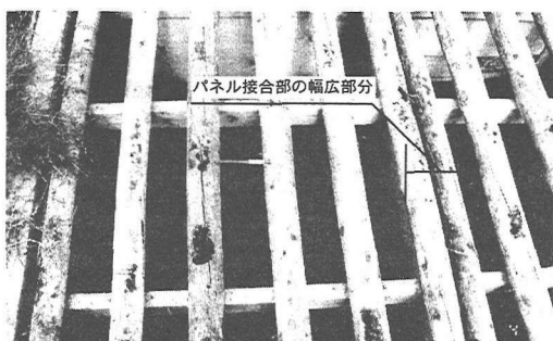
写真4 ディアガードの設置状況
