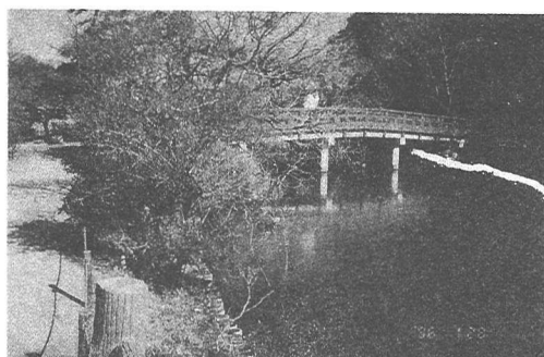
写真-4 \beta 11 撮影方向1:側面より撮影 三溪園, 水幅14m
