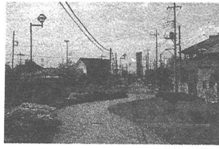
図-15 下流800m付近からみた 相模原調圧水槽
