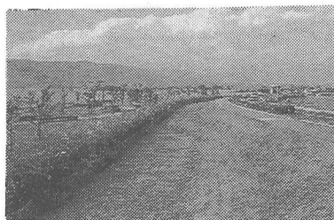
松林（植樹されたクロマツ）に沿って走る湖岸堤・管理用道路
