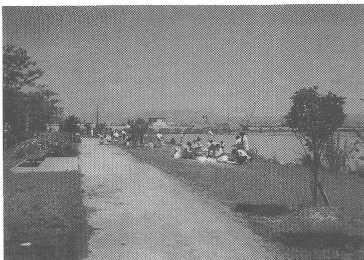
湖岸堤管理用道路前浜の湖岸緑地（草津市・志那地区の一部）
