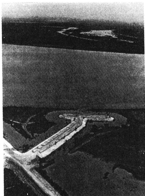
写真1 T字型突堤 7)
